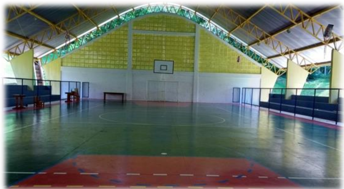
Figura 17 – Interior da quadra poliesportiva.
