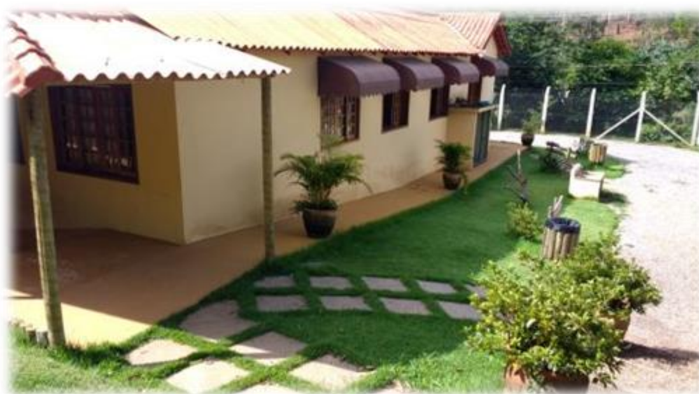
Figura 11 – Vista lateral dos fundos do prédio antigo.
