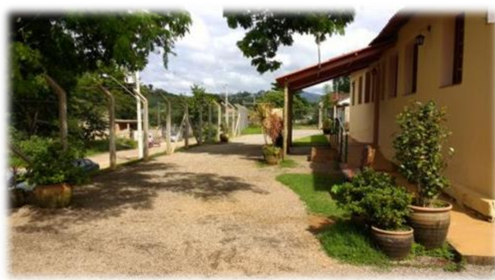
Figura 10 – Vista lateral do prédio antigo.
